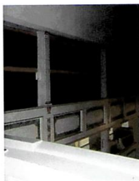
Abdeckung der Empore Schutz des Innenraumes für die Erneuerung der inneren Verkleidung
