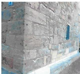
Turmgemäuer Strukturelle Schäden am Gemäuer wurden behoben und aufgewertet
