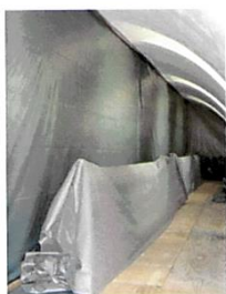
Abdeckung der Empore Schutz des Innenraumes für die Erneuerung der inneren Verkleidung
