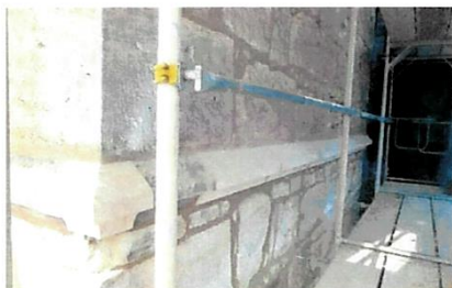
Gesimsfragmente Die zurückgebliebenen Fragmente wurde erneuert und vervollständigt
