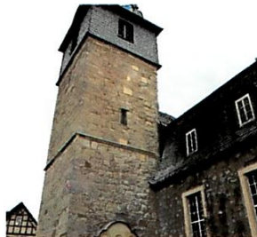
Glockenturm Neue Fassade sowie Dach des Glockenturmes
