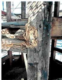
Turmgebälk Schäden am Holzgebälk des Glockenturmes beeinflussen die Statik
