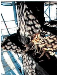
Turmgebälk Schäden am Holzgebälk des Glockenturmes beeinflussen die Statik
