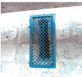
Schutzgitter Außenliegende Schutzgitter in neuem Zustand auf der erneuerten Fassade
