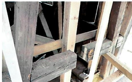
Turmgebälk Die Konstruktion wird durch neue Balken verstärkt
