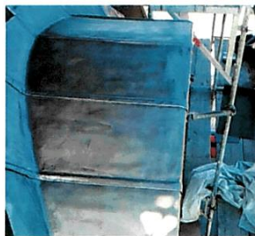
Dach des Glockenturmes Neue Eindeckung der Gauen mit Blei
