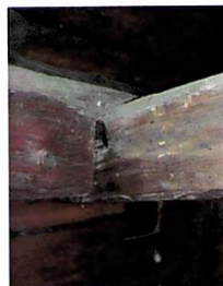
Dachgebälk Schadhafte Dachbalken im Dach des Kirchenschiffes
