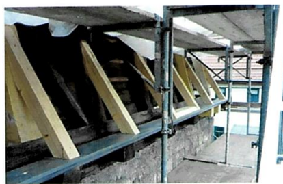
Dachgebälk Beschädigte Dachbalken wurden durch neue ersetzt
