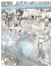
Turmgemäuer Heruntergekommenes Gemäuer und Risse in der Fassade bedrohen die Statik
