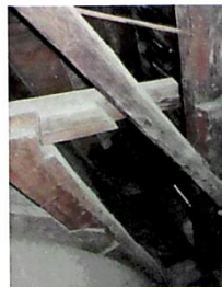
Dachgebälk Schadhafte Dachbalken im Dach des Kirchenschiffes
