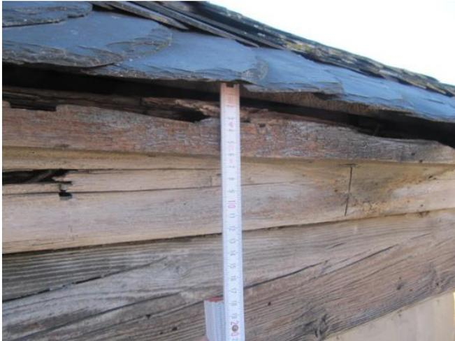
Durch Bauuntersuchungen in den vergangenen 20 Jahren wurden größere Schäden an der Holzkonstruktion des Turmes und des Daches festgestellt. Es sind einmal Schäden durch Trockenfäule, Insekten, Vogelkot und Verwitterung. Weiterhin aber auch statische Probleme durch kaputte Versteifungen und zerstörte Zapfen.
